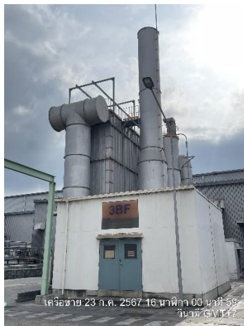
Bag Filter no.3 (MRM) สำหรับนำอลูมิเนียมกลับมาใช้ใหม่
