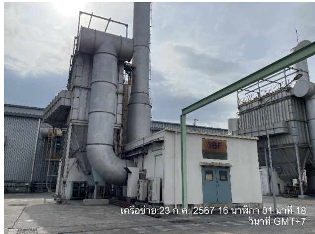
Bag Filter no.3 (MRM) สำหรับนำอลูมิเนียมกลับมาใช้ใหม่
