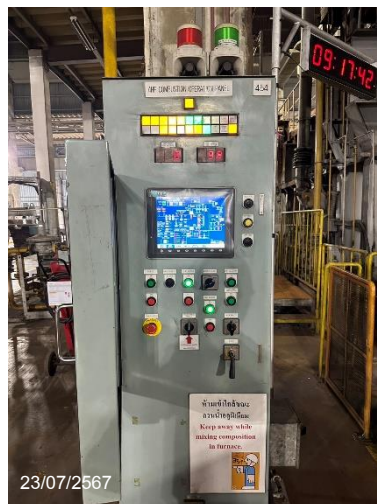
ภาพที่ 2-34 COMBINATION BOX W/MANUAL STATION LOCATION LAMP&ALARM BELL บริเวณเตาหลอม
