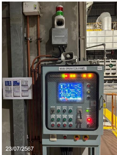
ภาพที่ 2-34 COMBINATION BOX W/MANUAL STATION LOCATION LAMP&ALARM BELL บริเวณเตาหลอม
