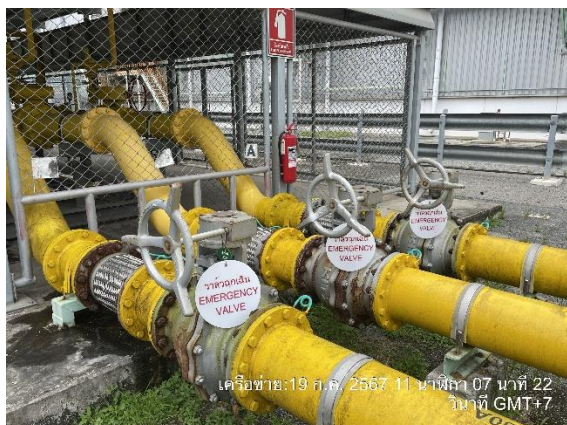
ภาพที่ 2-39 ระบบท่อ By pass และระบบวาล์วสำรอง กรณีเกิดความบกพร่องของเส้นท่อหลัก
