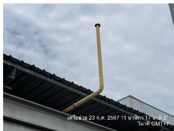
ภาพที่ 2-40 ปล่องระบายก๊าซ (Blow down stack)
