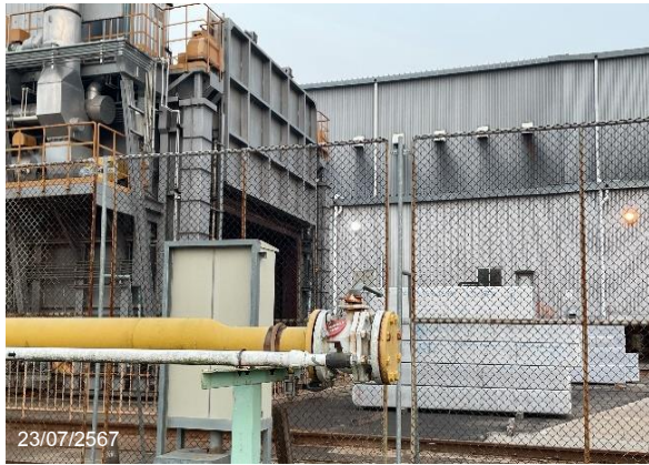
ภาพที่ 2-37 (ต่อ) Insulation Joint/Flang
