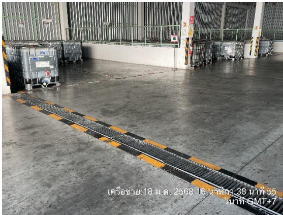
ภาพที่ 2-47 รางระบายน้ำและบ่อรวบรวมน้ำเสียบริเวณอาคารเก็บกากของเสีย
