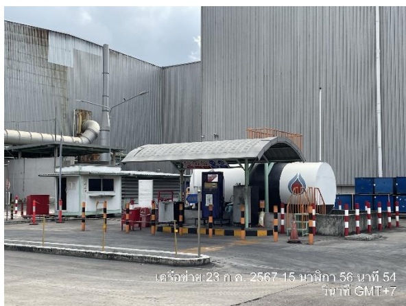
ภาพที่ 2-35 สถานีเติมน้ำมันดีเซลขนาด 20 ลูกบาศก์เมตร
